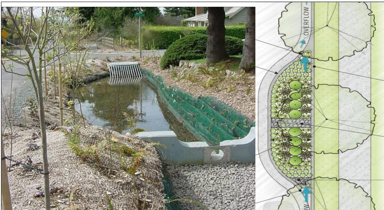
Figure 19 : Drainage des eaux pluviales provenant des chemins projetés et des stationnements vers des jardins pluviaux source (source : AHBL).
