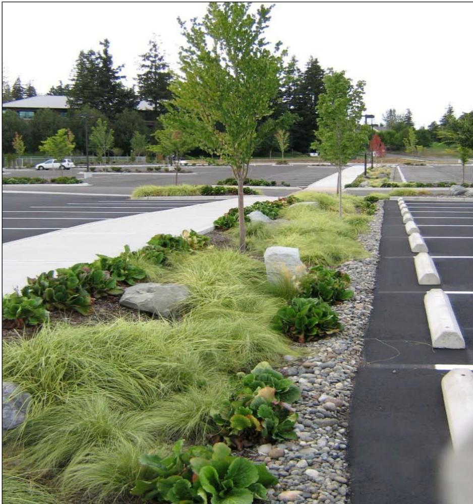
Figure 22 : Utilisation de la biorétention dans l'aménagement des espaces de stationnement (source : AHBL).
