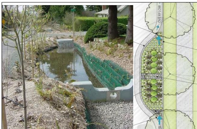
Drainage des eaux pluviales provenant des chemins projetés et des stationnements vers des jardins pluviaux source.
